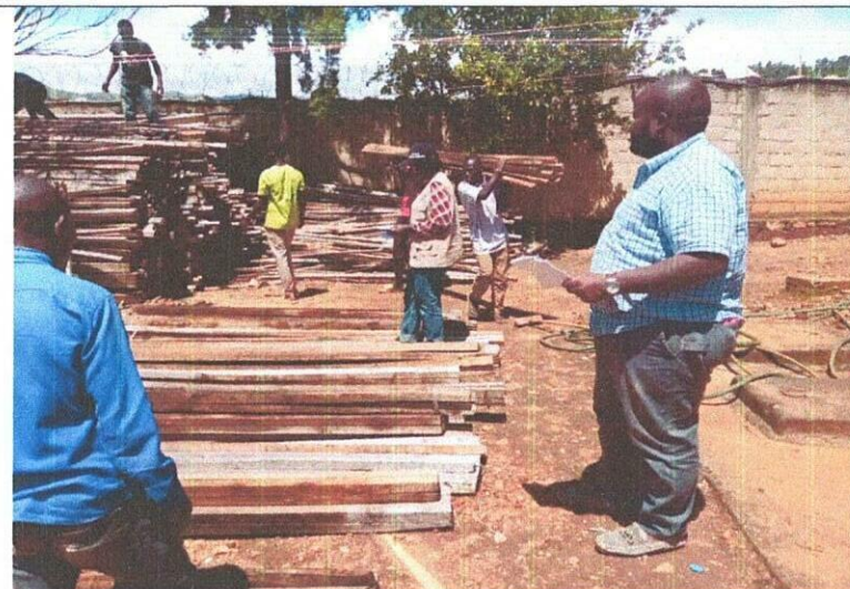
Entreposage des matériels et matériaux au sein dans l'enclos du bureau ZOA
